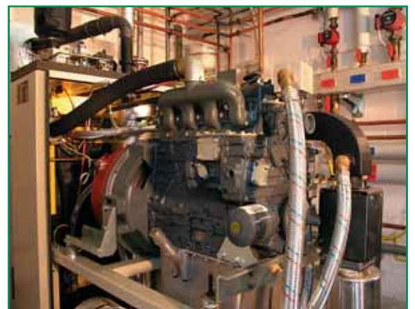
Kraft-Wärme-Kopplung liefert Strom und Wärme
